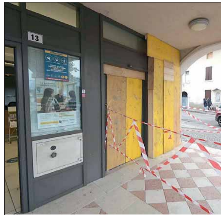
L'ingresso dopo la sistemazione provvisoria da parte dei vigili del fuoco
